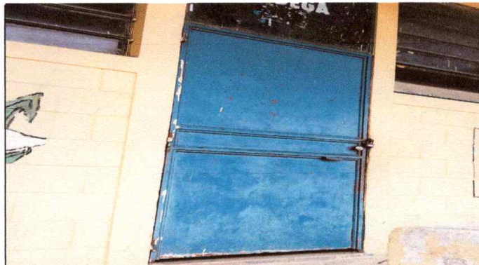
Foto: 4 Sustitución de puertas modulo 1
