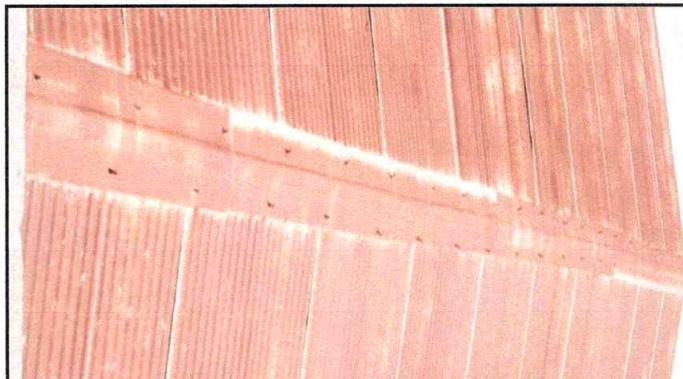
Foto 2: Sustitución de capote de lámina para lámina troquelada en modulo 1
