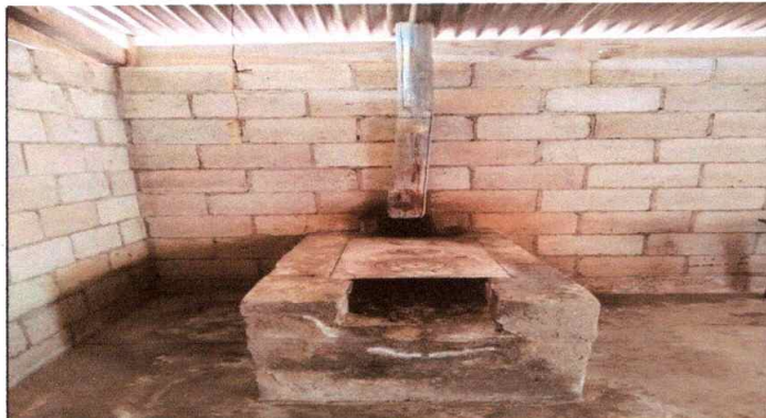
Foto: 15 Sustitución de estufa rural (completa) incluye chimenea y plancha de metal
