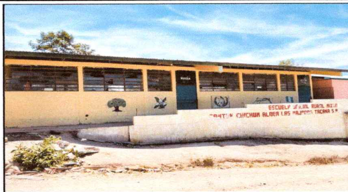
Foto: 8 Pintura en muros exteriores e interiores modulo 1
