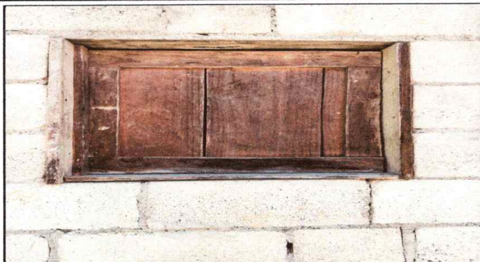
Foto: 13 Sustitución de ventana de madera por metal más vidrio cocina
