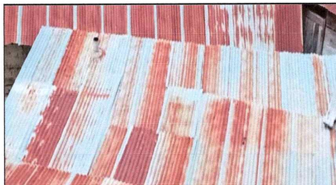
Foto: 10 Sustitución de lámina, por lámina troquelada cocina
