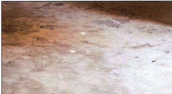
Foto: 14 Sustitución de piso de cemento por piso ceramico cocina
