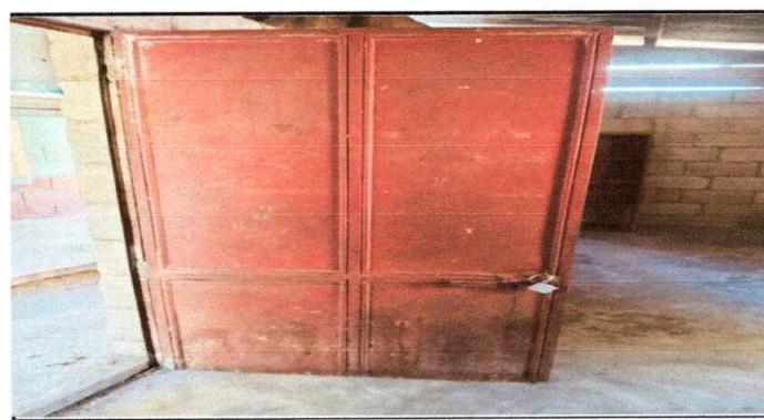
Foto: 12 Sustitución de puerta
