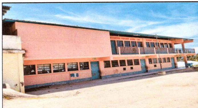
Foto: 9 Pintura en muros exteriores e interiores modulo 2
