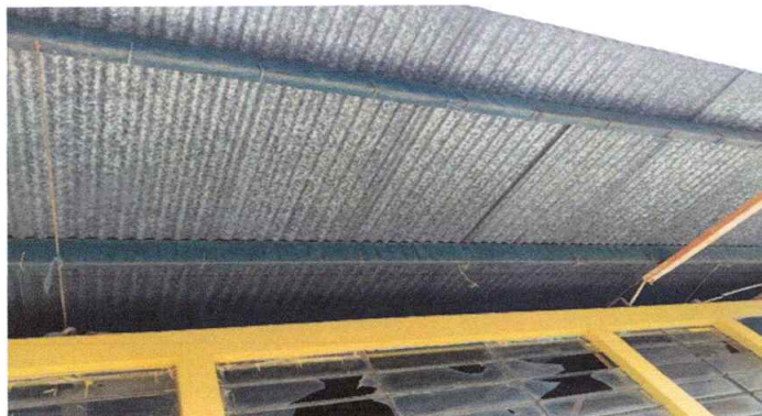
Foto: 3 Mantenimineto a estructura de soporte de metal modulo 1
