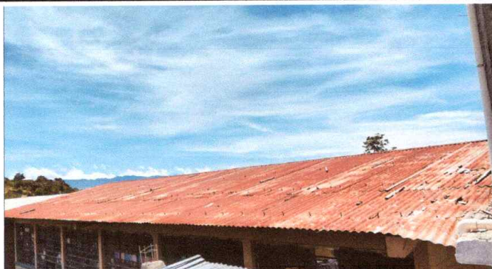
Foto 1: Sustitución de lámina por lamina troquelada aluzunc calibre 26
