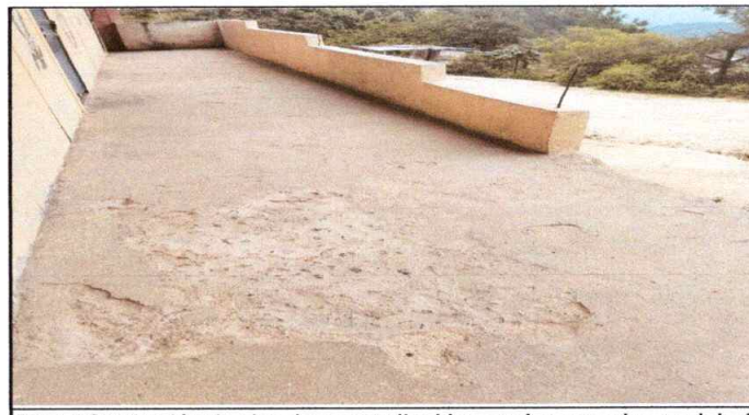
Foto: 6 Sustitución de piso de cemeto liquido por piso ceramico modulo 1
